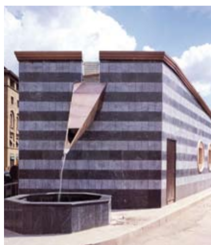
La pensilina vista dalla palazzina Reale
